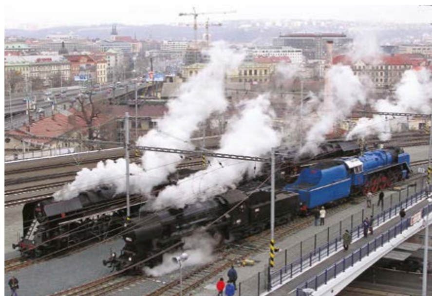
ZATĚŽKÁVACÍ ZKOUŠKA PŘEMOSTĚNÍ U HLAVNÍHO NÁDRAŽÍ (ROK 2004)
