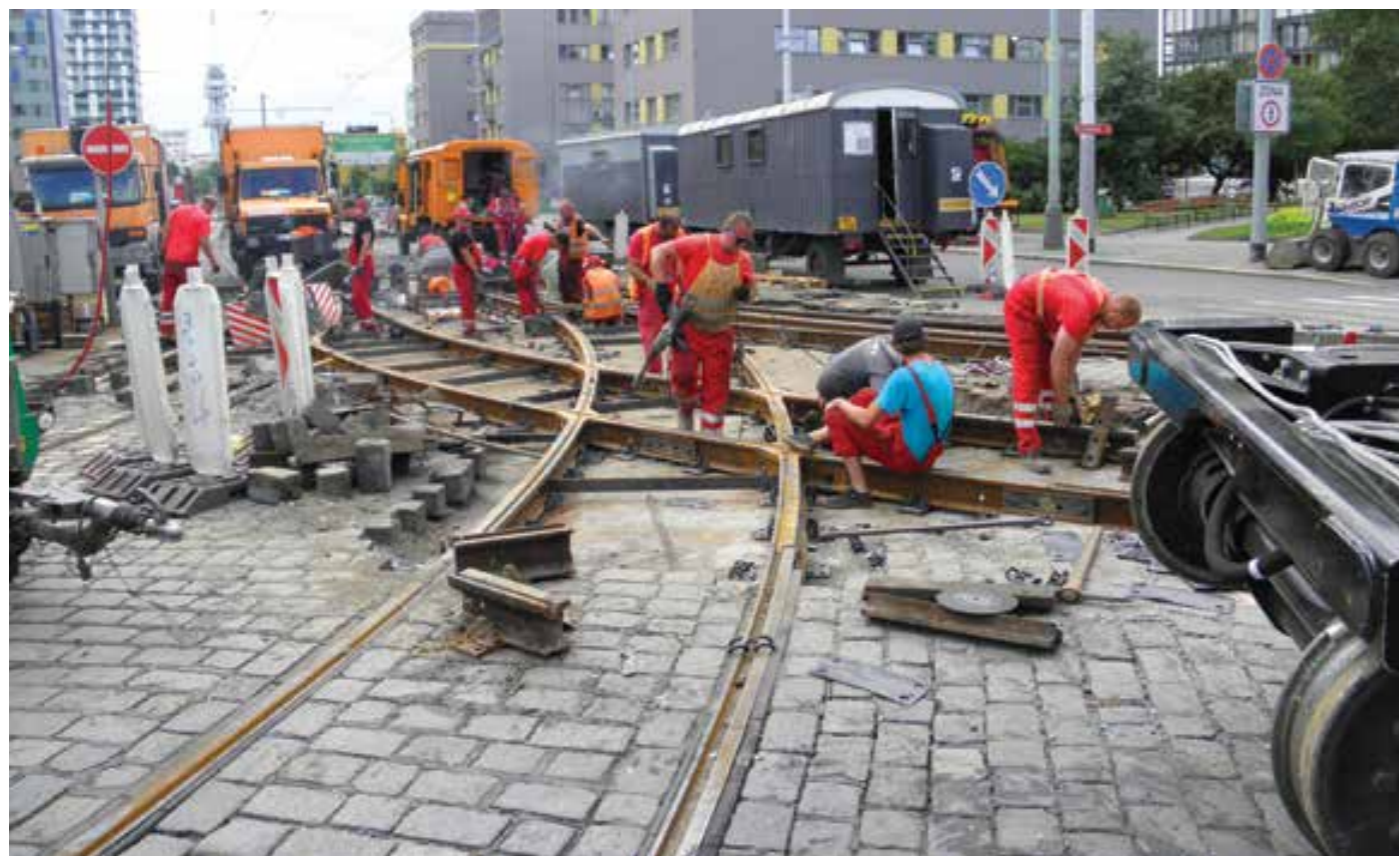
ROZVĚTVENÍ NA KŘIŽOVATCE NÁKLADOVÉ NÁDRAŽÍ. KAŽDÝ Z PRACOVNÍKŮ MUSÍ ZNÁT PRACOVNÍ POSTUP A VĚDĚT, CO MÁ V DANOU CHVÍLI DĚLAT
