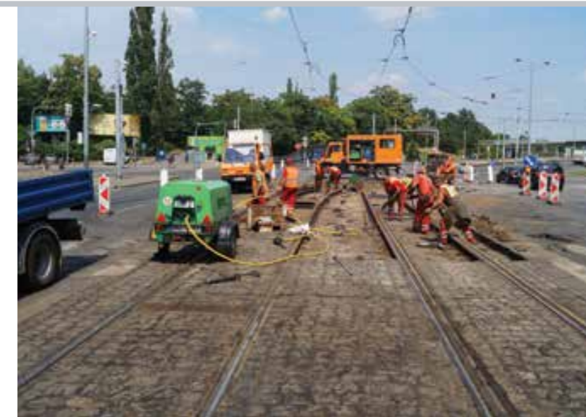
MONTÁŽ KOLEJOVÉ KONSTRUKCE V KŘIŽOVATCE OHRADA OD NÁKLADOVÉHO NÁDRAŽÍ SE ANI PŘI EXTREMNÍCH TEPLOTÁCH ZASTAVIT NEMOHLA
