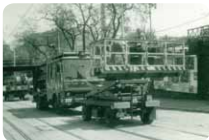
Také tento snímek patří k dost výjimečným. O tom, že v Praze byla přívěsná zvedací plošina, ví asi dost lidí. Ovšem fotek, na nichž je zachycena přímo v akci, je jak šafránu. Zde se nachází při práci na obnově vrchního vedení pod železničním podjezdem v ulici U Výstaviště 30. dubna 2001.
