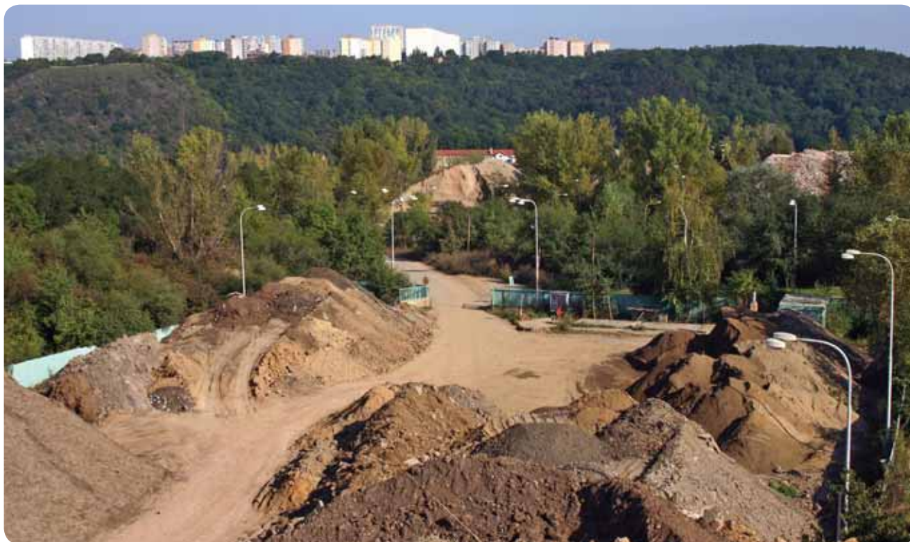
Pohled na vyvezenou zeminu deponovanou dne 24. září 2005 na bývalé odstavné ploše autobusů v Suchdole.
