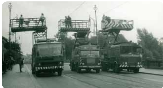
Velmi hezká sestava montážních automobilů se nám sešla na mostě Legií. Můžeme si dobře prostudovat rozdíly nejen mezi jednotlivými typy vozidel, ale i mezi samotnými montážními plošinami. Fotořafováno 29. září 1991.
