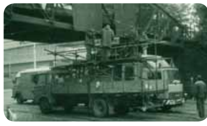
Na závěr pojednání o „drátenických“ automobilech jsem si nechal opravdovou kuriozitu z doby celkem nedávné, z 16. října 1994. Na začátku byla vlastně banální záležitost – stržená trolej v podjezdu u Výstaviště. Nízká podjezdná výška spolu s momentálním nedostatkem vhodných montážních vozů stály u zrodu skutečně netradičního řešení. Ale, jak se říká, účel světí prostředky. A cíle bylo dosaženo...
