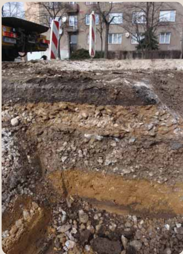
Archeologie velmi pěkně ukazuje příčinu mnoha nedostatků – šizené horní konstrukční vrstvy z roku 1990 byly uloženy na znečištěný štěrk z roku 1976.
