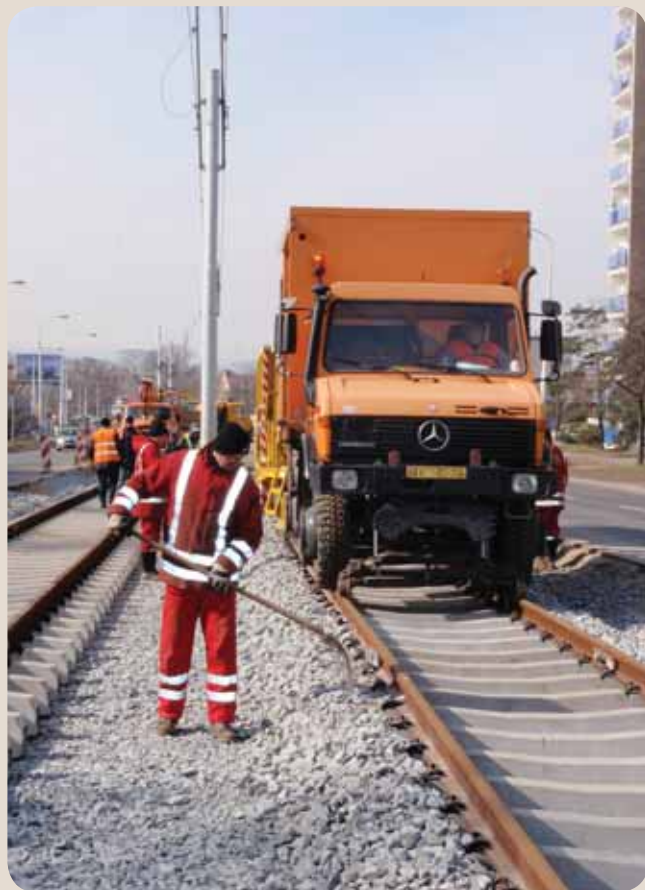
Štěrkování trati dvoucestným automobilem a kolejovou štěrkovačkou.
