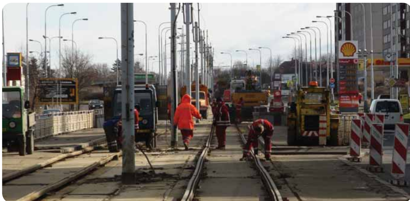
Stavba několik hodin po zahájení tramvajové výluky.
