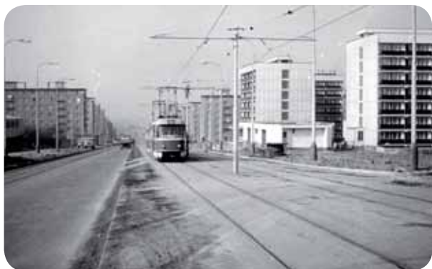
Poděbradská třída mezi zastávkami Slévačská a Černý most 16. března 1977. Povrchové práce u smyčky ještě nejsou hotovy ani víc jak osm měsíců po zahájení provozu. Foto: Jiří Čermák
