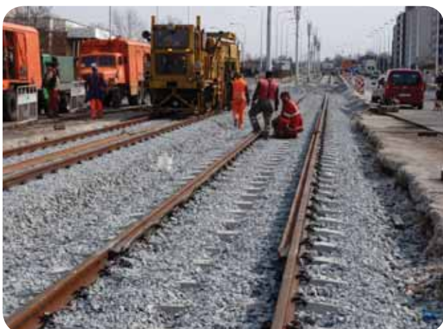
Rodící se přejezd se Slévačskou ulicí ukazuje použití přídatného profilu v celé výšce.
