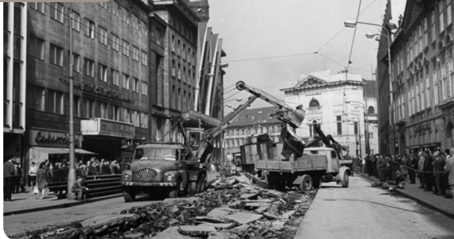
Rekonstrukce tratě v ulici Na Příkopě, provedená původně v roce 1964, se už o dva roky později musela celá opakovat. Snímek ukazuje první den prací v září 1966.
