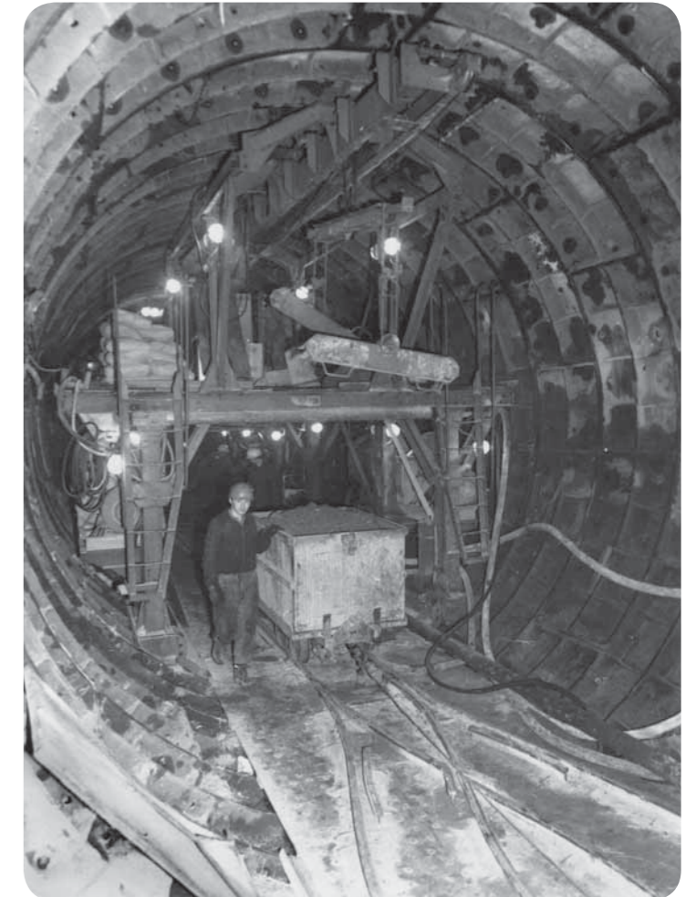
Je 31. března 1969. První razicí štít pracuje na Pankráci jedenáctý den
