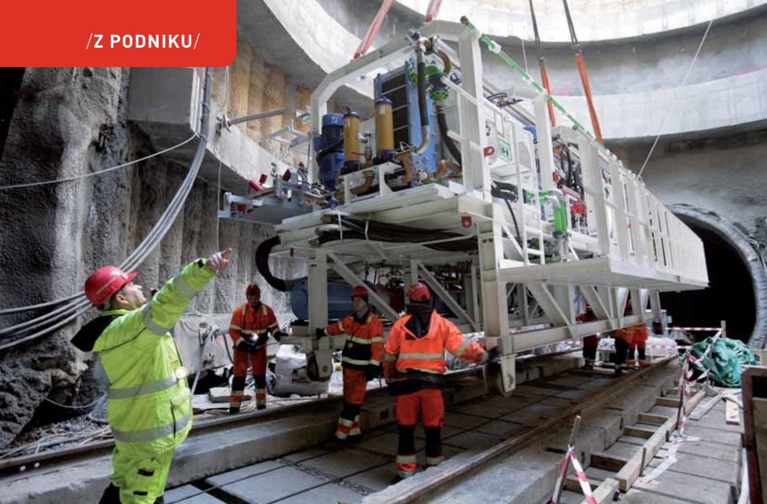
Dno montážní jámy na Vypichu – ukládání vozíků na kolejové lože
