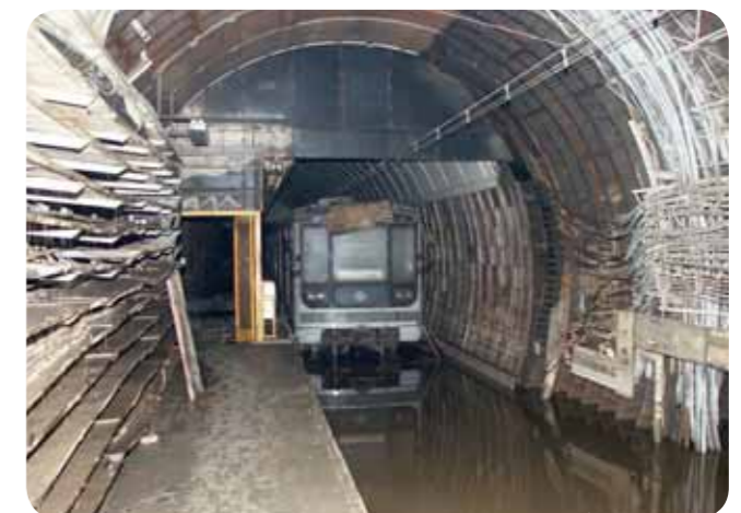
19. září 2002, zaplavená souprava ve stanici pražského metra Florenc
