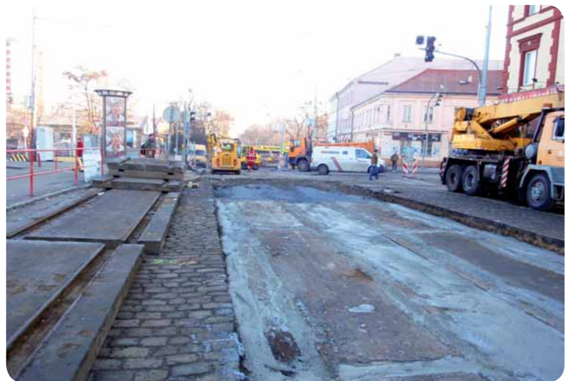
Spodní panely vytvářející podkladovou desku byly zabetonovány a posléze překryty živičí
