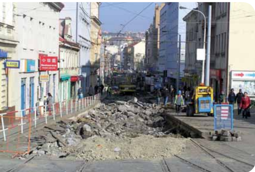
Přesně týden po zahájení prací v březnu 2011 byla trat' v Zenklově ulici k nepoznání
