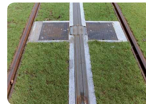
Systém napájení APS třetí kolejnicí v detailu
