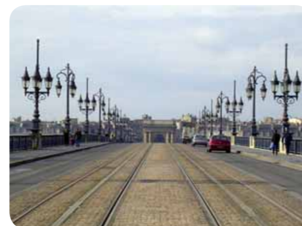
Systém napájení APS na historickém Kamenném mostě
