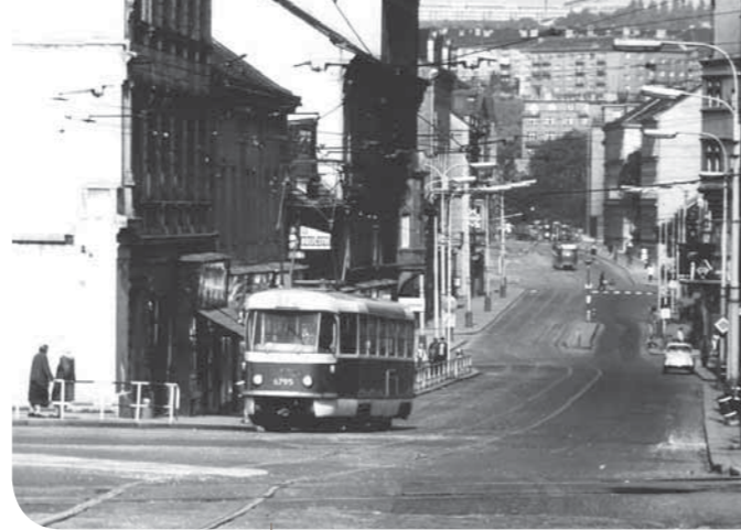
Fotografie z roku 1972 zachycuje tramvaj, která opouští úsek nynější rekonstrukce. V popředí je železniční přejezd přes dnes již zaniklou trať. Horní a dolní Palmovku spojovala jen jedna kolej
