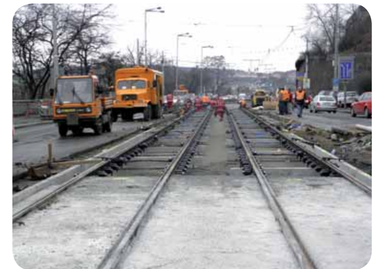
Nábřeží Kpt. Jaroše je dalším místem s konstrukcí trati systémem W-tram. V popředí je zabetonovaný úsek, vzdálenější část se k betonáži připravuje
