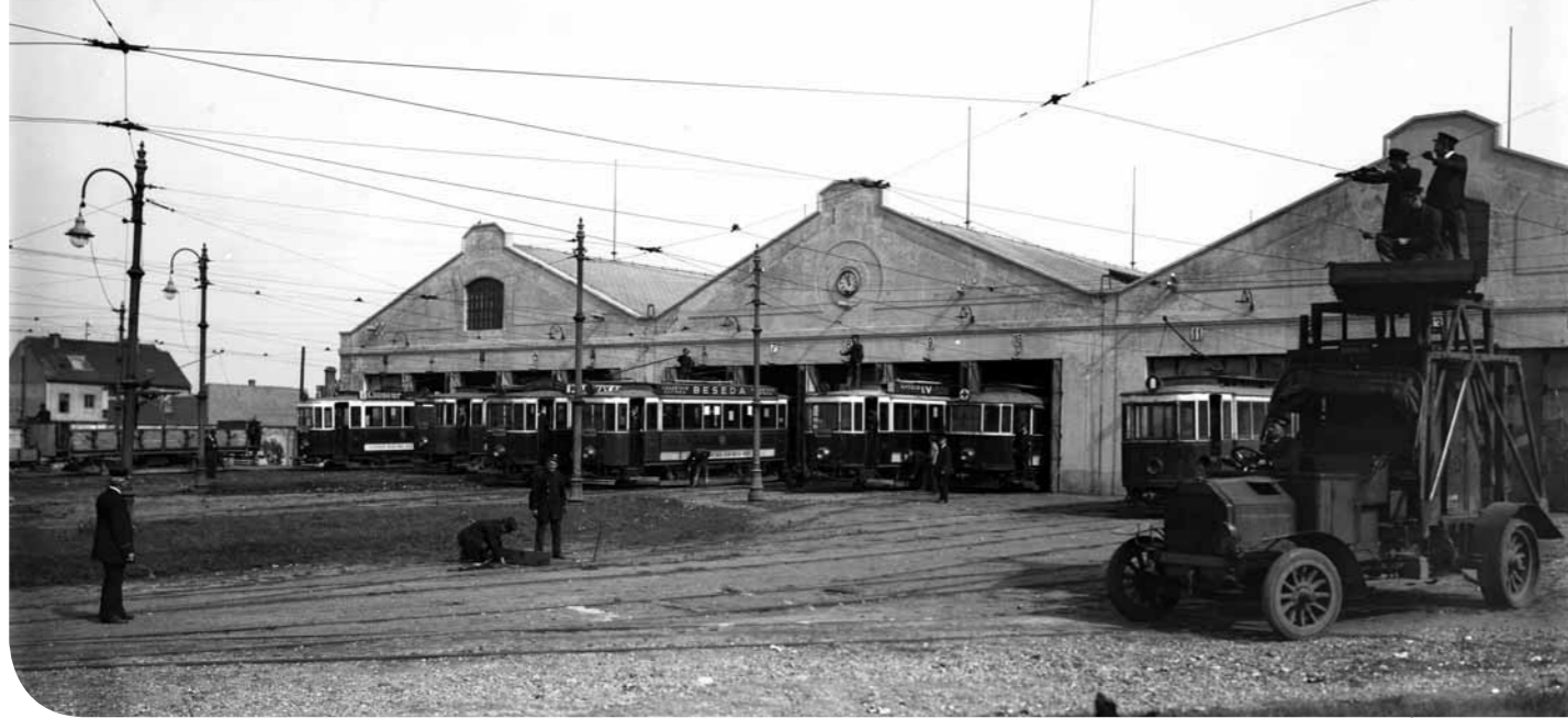
Snímek dvoru vozovny byl pořízen někdy během první světové války. Fotografii „zapózovaly“ nejen tramvaje, ale svoji práci připomněli zaměstnanci různých profesí – opraváři výhybek, trolejového vedení, vřadu je nákladní vůz, máme tu i tramvajovou sanitku
