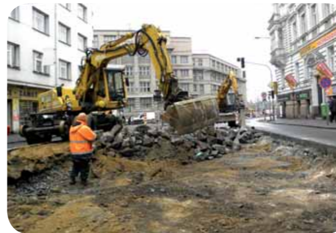
Takto vypadal pátý den prací prostor zastávky Strossmayerovo náměstí
