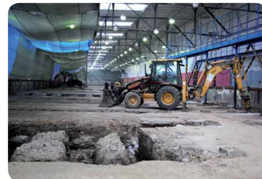
Přestavba motolské vozovny je tím příkladem, který se dotýká více úseků v rámci jednoho objektu, a je tedy námětem pro manažera projektu
