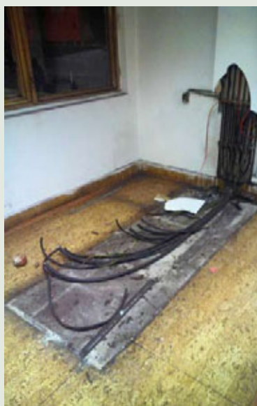
Dole: Zmíněná část „gordického uzlu“ – kabely připravené na přepojení zařízení.
