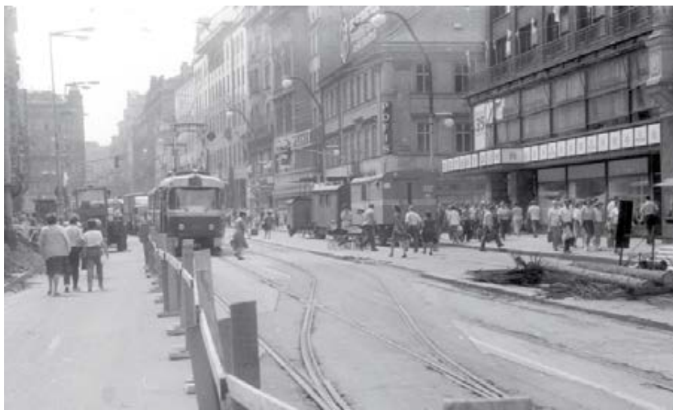
Ulice Na Příkopě před Dětským domem 29. května 1985. Tramvaje jezdí po jedné koleji, lidé chodí, kde se dá.
