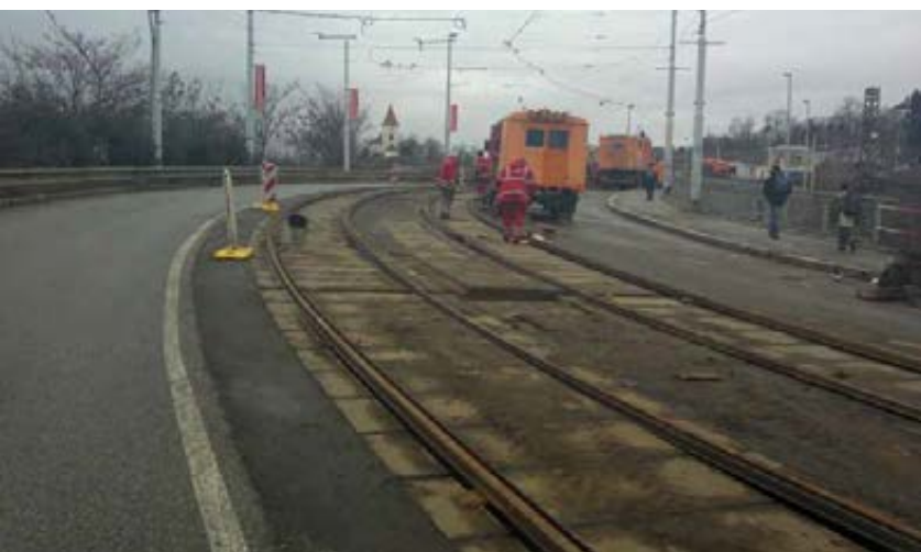
Souvislá výměna kolejnic na předmostí u Lihovaru, 2013.
