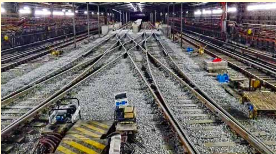
Sanace výhybek ve stanici Kačerov.
