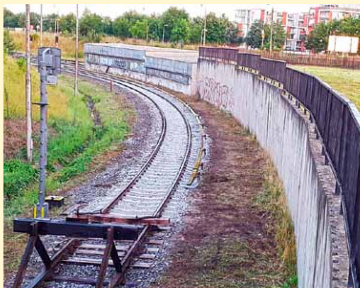
Pohled na dokončenou kolej 4a.
