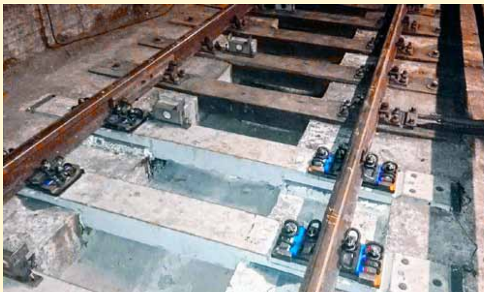
Výměna starých dřevěných pražců v úseku Pankrác – Budějovická.
