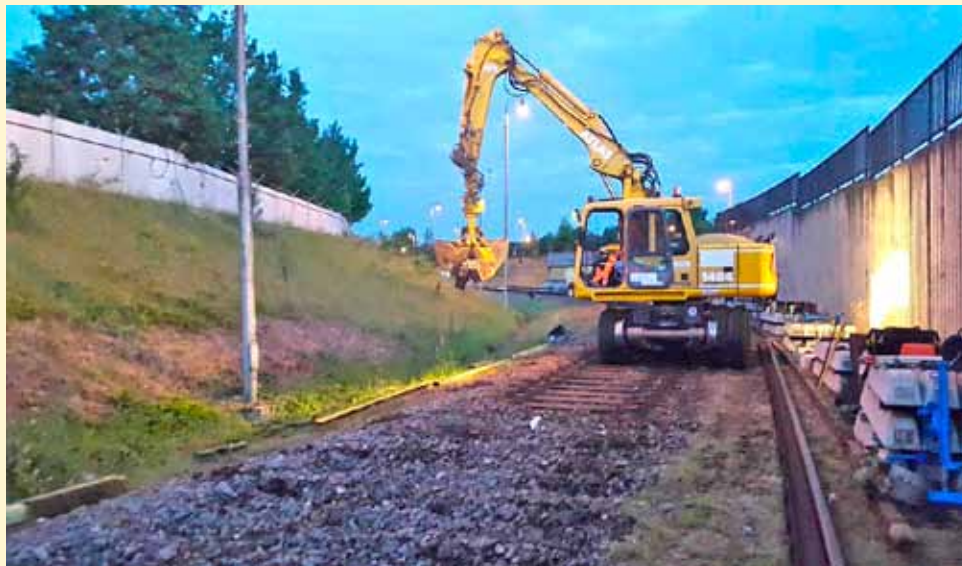
Nahore: Dvoucestný bagr při práci na sanaci koleji 4a v depu Zličín.
