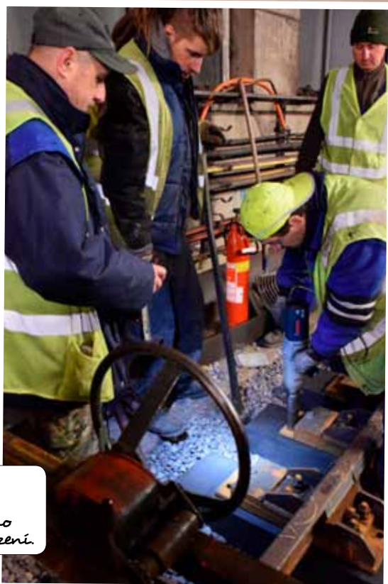
To je ona! 13,8 metru dlouhá nová kolejová dilatace s pohyblivou kolennou kolejnicí, díky níž soupravy metra vjezdějí do mostu po hrotu kolejnice, tedy tišeji.
