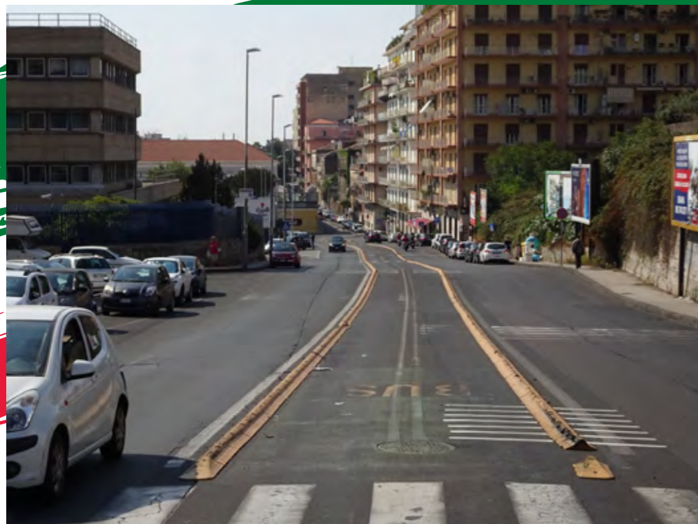
CATANIA A JEDNO Z MÁLA PREFERENČNÍCH OPATŘENÍ V PODOBĚ VYHRAZENÉHO PRUHU PRO AUTOBUSY NA VIA ALA. PRUH SLOUŽÍCÍ LINCE BRT 1, JE OFICIÁLNĚ JEDNOSMĚRNÝ, OVŠEM KDYŽ TO VYJDE, VYUŽÍVAJÍ HO I AUTOBUSY V OPAČNÉM SMĚRU FOTO: JAN MAREK
