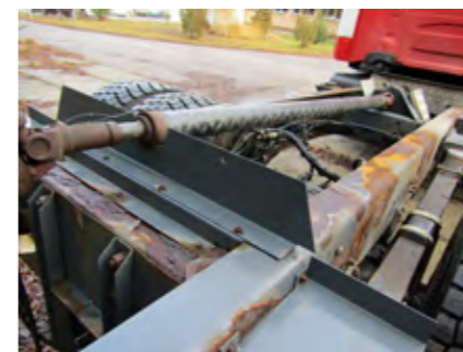
KOROZE RÁMU VOZU PO SEJMUTÍ NÁSTAVBY FOTO: ANZA
