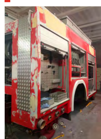
OPRAVA NÁSTAVBY A PŘÍPRAVA NA LAKOVÁNÍ FOTO: ANZA
