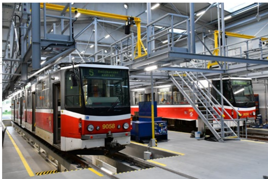
V PRVNÍ ČÁSTI HALY JSOU MONTÁŽNÍ KANÁLY A LÁVKY, POMOCÍ KTERÝCH SE VŮZ MŮŽE SERVISOVAT SOUČASNĚ JAK ZDOLA, TAK SHORA
