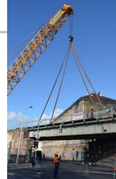
ÚNOR 2018 – V SOUVISLOSTI S DEMOLICÍ MOSTU V ULICI PRVNÍHO PLUKU BYLY LINKY ČÍSLO 133, 135, 175, 207, 908 A 909 VEDENY PO ODKLONOVÝCH TRASÁCH
