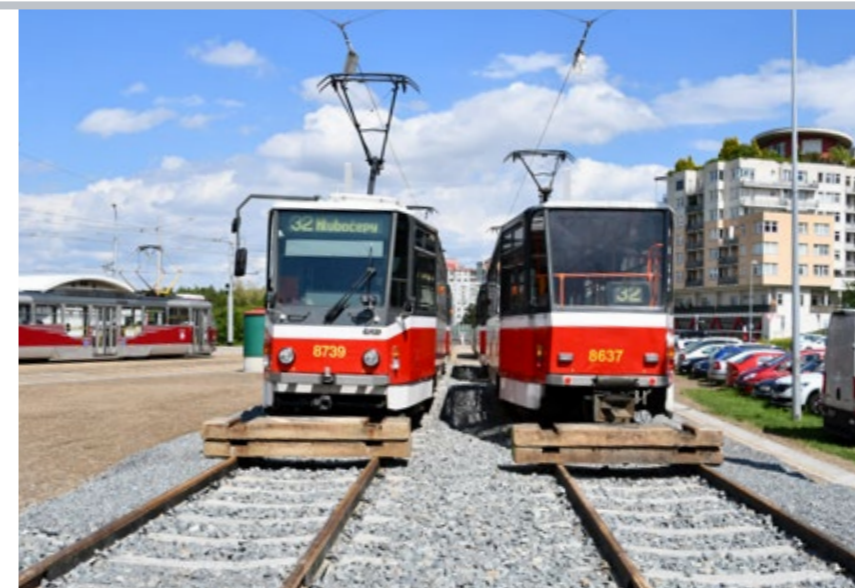
ČTYŘICETIMETROVÝ ÚSEK BUDOUCÍ TRATI SMĚR SLIVENEČ VEDE ZE SMYČKY SÍDLIŠTĚ BARRANDOV
