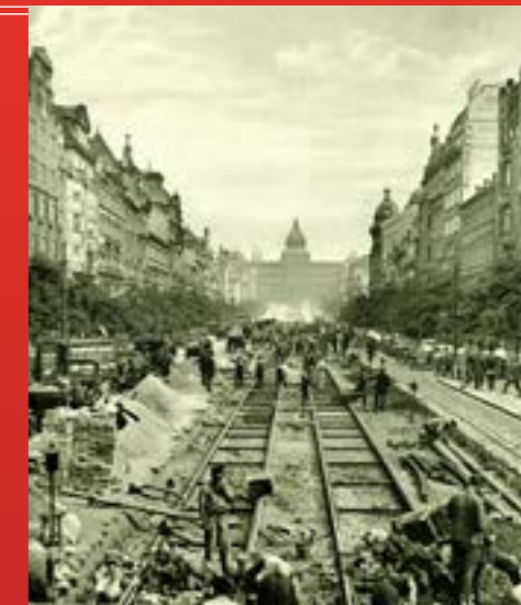
V LETECH 1927 AŽ 1928, TĚMĚŘ TRICET LET OD ELEKTRIFIKACE TRAMVAJÍ, PROBIHÁ NA VÁCLAVSKÉM NÁMĚSTÍ PRVNÍ ZÁSADNÍ PŘESTAVBA OBNAŠEJÍCÍ PŘELOŽKU TRAMVAJOVÝCH KOLEJÍ NA STŘEDOVÝ ZVÝŠENÝ PÁS MEZI SOCHOU SV. VÁCLAVA A MŮSTKEM, REKONSTRUKCI KOMUNIKACE I INŽENÝRSKÝCH SÍTÍ. OSOVÁ VZDÁLENOST JE JIŽ STANDARDNÍCH 2,8 M. V DUBNU 1928 JE TU DOKONČENA TAKÉ REKONSTRUKCE V OBLASTI PŘED MUZEEM. (REPRO Z ČASOPISU PESTRÝ TÝDEN)
