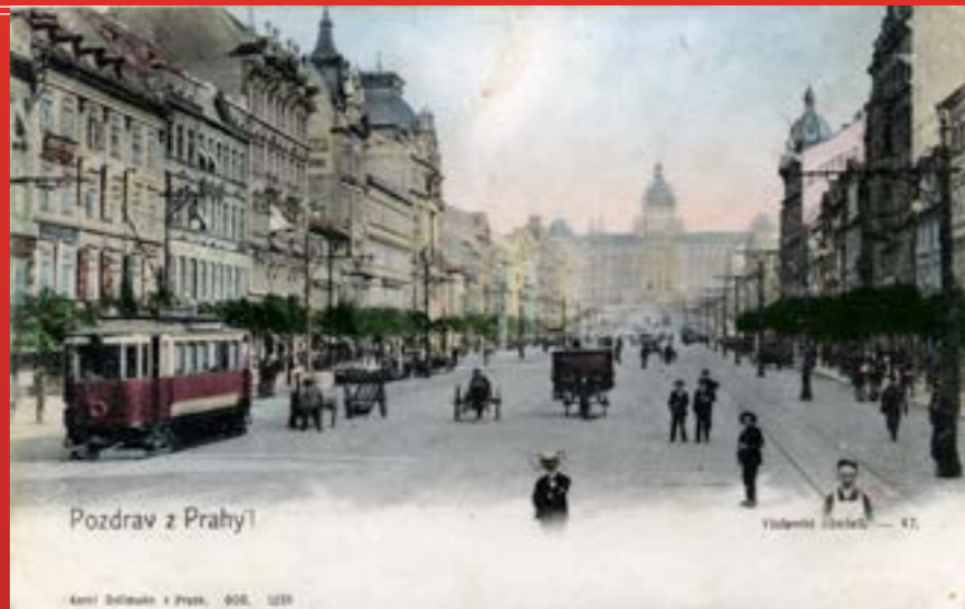
V ROCE 1900 PŘÍCHÁZÍ NA VÁCLAVSKÉ NÁMĚSTÍ ELEKTRICKÁ DRAHA, KTERÁ SE STÁVÁ JEHO NEDÍLNOU SOUČÁSTÍ NA DALŠÍCH OSMDEŠÁT LET. ELEKTRIFIKACE KOŇSKÉ DRAHY ZDE PROBIHALA ZA PROVOZU A KOLEJE BYLY PŘEKLÁDÁNY DO NOVÉ POLOHY. OSOVÁ VZDÁLENOST ČINÍ NOVĚ 16 M A TRATĚ JE LEMOVÁNA SLOUPY S VÝLOŽNÍKY. ELEKTRICKÝ PROVOZ JE ZAHÁJEN OD 23. 6. 1900. (DOBOVÁ POGLEDNICE, STAV KOLEM ROKU 1905)
