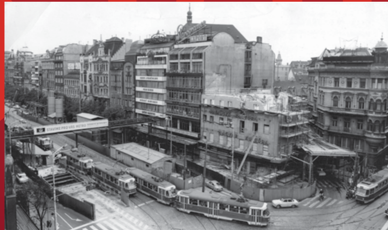
ZPROVOZNĚNÍM PRVNÍ LINKY METRA BUDOVA TELESKOPICKÉ STAVBY METRA V HISTORICKÉM CENTRU ANI ZDALEKA NEKONČÍ. ZVLÁŠTĚ NÁROČNÁ JE VÝSTAVBA STANICE A VESTIBULŮ V OBLASTI MŮSTKU. V LETECH 1975 AŽ 1977, ZACHYCENÁ NA NAŠEM SNIMKU, VÁCLAVÁK JE V TĚTO ETAPĚ JEDNÍM VELKÝM STAVENÍŠTĚM. (ARCHIV DPP)
