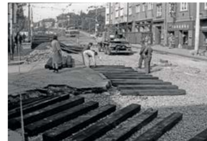
SNÍMEK Z ROKU 1986, KDE JE VIDĚT PROBÍHAJÍCÍ REKONSTRUKCI TRATI U SPODNÍCH VRAT VOZOVNY. TRATĚ U HORNÍCH VRAT PŘIŠLA NA ŘADU AŽ V ROCE 1991 A NAMÍSTO PRAŽCŮ TAM BYLY POUŽITY PODKLADOVÉ VUIS PANELE
