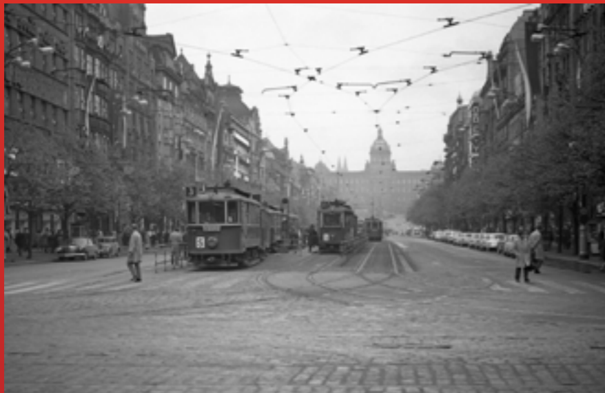
V ROCE 1947 PROCHÁZÍ ZÁSADNÍ ÚPRAVU KŘÍŽOVATKA NA MŮSTKU, KDE JSOU ZŘÍZENY TZV. PŘEDJÍZDNÉ KOLEJE VE SMĚRU OD MUZEA A OD PRAŠNÉ BRÁNY. STAVBA METRA, PŘIPRAVOVANÁ OD ROKU 1939, JE V NEDOHLEDNU A STRATEGICKÝM ÚKOLEM DOBY JE ZVYŠOVÁNÍ VÝKONNOSTI A CESTOVNÍ RYCHLOSTI TRAMVAJOVÉ DOPRAVY, ABY DOKÁZALA V DALŠÍCH LETECH ZVLÁDÁT TRVALE ROSTOUCÍ NÁROKY. JEDNOU Z MOŽNOSTÍ, JAK URYCHLIT PRŮJEZDY VYSOCE ZATÍŽENÝCH KŘÍŽOVATEK, JE BUDOVNÍ TZV. PŘEDJÍZDNÝCH KOLEJÍ, KTERÉ UMOŽNÍ ROZŘAZENÍ VLAKŮ PODLE SMĚRŮ JEŠTĚ PŘED KŘÍŽOVATKOU A ZASTÁVKAMI A TÍM ZRYCHLENÍ PRŮJEZDŮ VLAKŮ CELÝM UZLEM. SNÍMEK BYL POŘÍZEN V ROCE 1965, KDY DOPRAVĚ NA NÁMĚSTÍ STÁLE VLÁDLY DVOUNÁPRAVOVÉ TRAMVAJE. (LADISLAV REZŇÍČEK, SBÍRKA ROBERT MARA)
