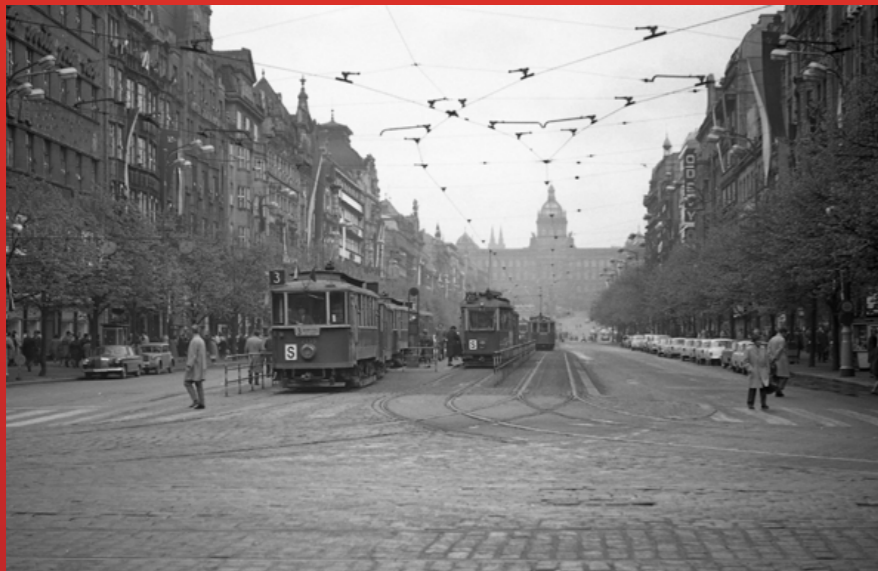
V ROCE 1947 PROCHÁZÍ ZÁSADNÍ ÚPRAVOU KŘÍŽOVATKA NA MŮSTKU, KDE JSOU ZŘÍZENY TZV. PŘEDJÍZDNÉ KOLEJE VE SMĚRU OD MUŽEA A OD PRAŠNÉ BRÁNY. STAVBA METRA, PŘIPRAVOVANÁ OD ROKU 1939, JE V NEDOHLEDNU A STRATEGICKÝM ÚKOLEM DOBY JE ZVYŠOVÁNÍ VÝKONNOSTI A CESTOVNÍ RYCHLOSTI TRAMVAJOVÉ DOPRAVY, ABY DOKÁZALA V DALŠÍCH LETECH ZVLÁDÁT TRVALE ROSTOUCÍ NÁROKY. JEDNOU Z MOŽNOSTÍ, JAK URYCHLIT PRŮJEZDY VYSOCE ZATÍŽENÝCH KŘÍŽOVATEK, JE BUDOVNÍ TZV. PŘEDJÍZDNÝCH KOLEJÍ, KTERÉ UMOŽNÍ ROZŘAZENÍ VLAKŮ PODLE SMĚRŮ JEŠTĚ PŘED KŘÍŽOVATKOU A ZASTÁVKAMI A TÍM ZRYCHLENÍ PRŮJEZDŮ VLAKŮ CELÝM ÚZLEM. SNÍMEK BYL POŘÍZEN V ROCE 1965, KDY DOPRAVĚ NA NÁMĚSTÍ STÁLE VLÁDLY DVOUNÁPRAVOVÉ TRAMVAJE. (LADISLAV REZŇÍČEK, SBÍRKA ROBERT MARA)
