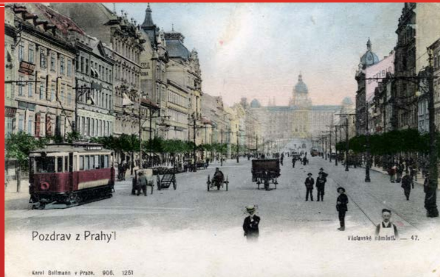
V ROCE 1900 PŘÍCHÁZÍ NA VÁCLAVSKÉ NÁMĚSTÍ ELEKTRICKÁ DRAHA, KTERÁ SE STÁVÁ JEHO NEDÍLNOU SOUČÁSTÍ NA DALŠÍCH OSMDEŠÁT LET. ELEKTRIFIKACE KOŇSKÉ DRAHY ZDE PROBIHLA ZA PROVOZU A KOLEJE BYLY PŘEKLÁDÁNY DO NOVÉ POLOHY. OSOVÁ VZDÁLENOST ČINÍ NOVĚ 16 M A TRATĚ JE LEMOVÁNA SLoupY S VÝLOŽNÍKY. ELEKTRICKÝ PROVOZ JE ZAHÁJEN OD 23. 6. 1900. (DOBOVÁ POGLEDNICE, STAV KOLEM ROKU 1905)
