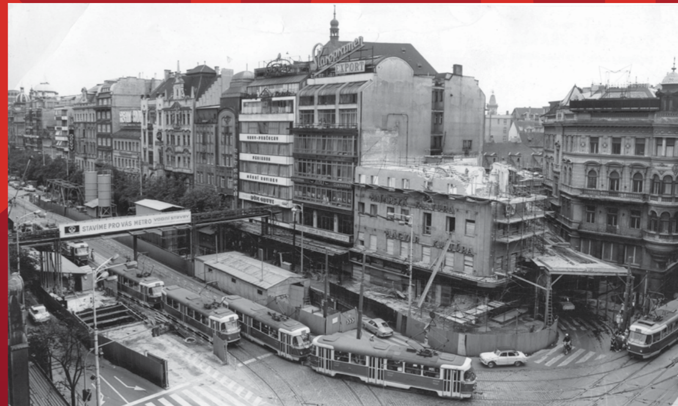
ZPROVOZNĚNÍM PRVNÍ LINKY METRA BUDOVAATELSKÉ MARTYRIUM SLOŽITÉ STAVBY METRA V HISTORICKÉM CENTRU ANI ZDALEKA NEKONČÍ. ZVLÁŠTĚ NÁROČNÁ JE VÝSTAVBA STANICE A VESTIBULŮ V OBLASTI MŮSTKU. V LETECH 1975 AŽ 1977, ZACHYCENÁ NA NAŠEM SNIMKU, VÁCLAVÁK JE V TĚTO ETAPĚ JEDNÍM VELKÝM STAVENIŠTĚM. (ARCHIV DPP)
