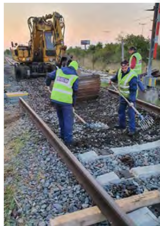
PRÁCE NA VLOŽENÍ NOVÉ VÝHYBKY NA ZKUŠEBNÍ TRATI DEPA ZLIČÍN
