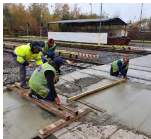
HOSTIVAŘSKÉ DEPO SE DOČKALO I OPRAVY POŽÁRNÍ KOMUNIKACE PŘES 1. A 2. STANIČNÍ KOLEJ
