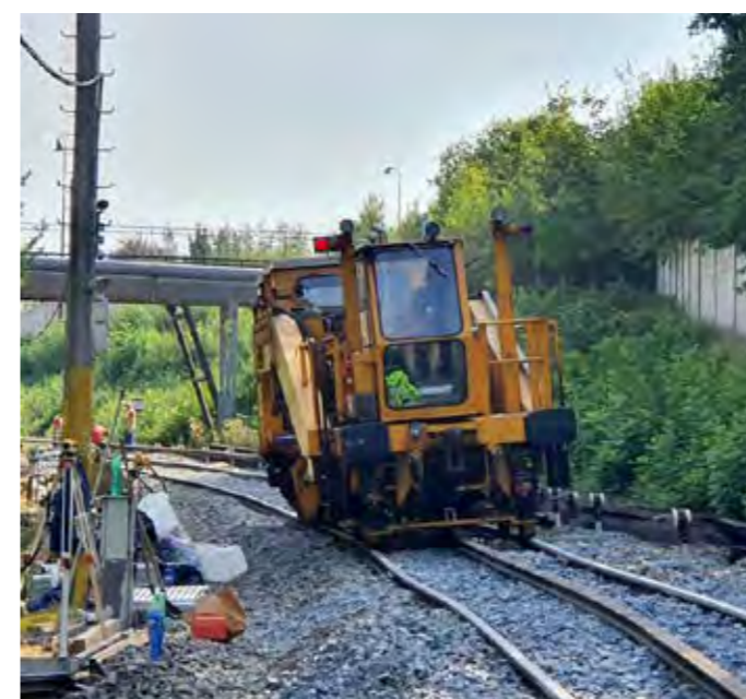
V DEPU HOSTIVAŘ BYLO TŘEBA VYMĚNIT PRAŽCE V DÉLCE 200 METRŮ NA ZKUŠEBNÍ TRATI
