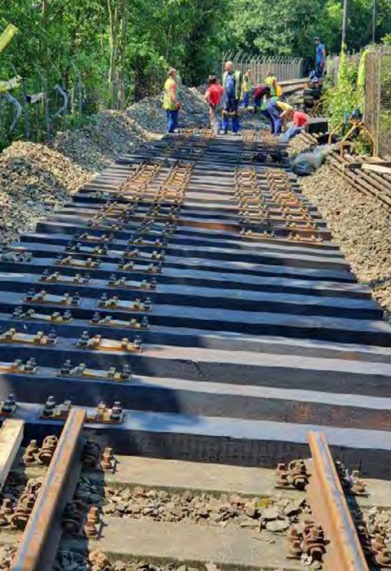
Z VÝMĚNY SPLÍTKOVÉ VÝHYBKY NA ZKUŠEBNÍ TRATI DEPA KAČEROV
