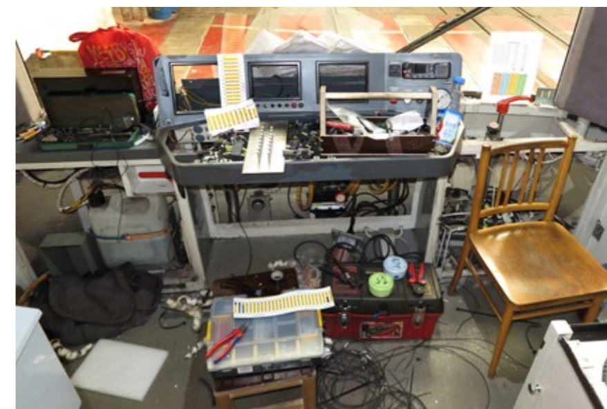
POHLED NA PULT STROJVEDOUČÍHO ČELNÍHO VOZU 3138 V ČASE PŘESTAVBY MOBILNÍ ČÁSTI LINIOVÉHO VLAKOVÉHO ZABEZPEČOVAČE ARS/LZA. FOTOGRAFIE Z 2. 8. 2021 ZACHYCUJE NÁROČNOST MONTÁŽE LZA PŘI ZACHOVÁNÍ ARS. VODIČE BYLO NUTNÉ CITLIVĚ ODPOJIT, ZAIZOLOVAT, PEČLIVĚ POPSAT A VYVÁZAT. KONEČNÝ STAV PAK MUSEL BÝT ZAZNAMENÁN DO NOVĚ VZNIKLÉ DOKUMENTACE A SCHÉMAT. TO VŠE UMOŽNÍ BUDOUCÍ OPĚTOVNĚ OŽIVENÍ ARS DO HISTORICKY PREZENTOVATELNÉ PODOBY
