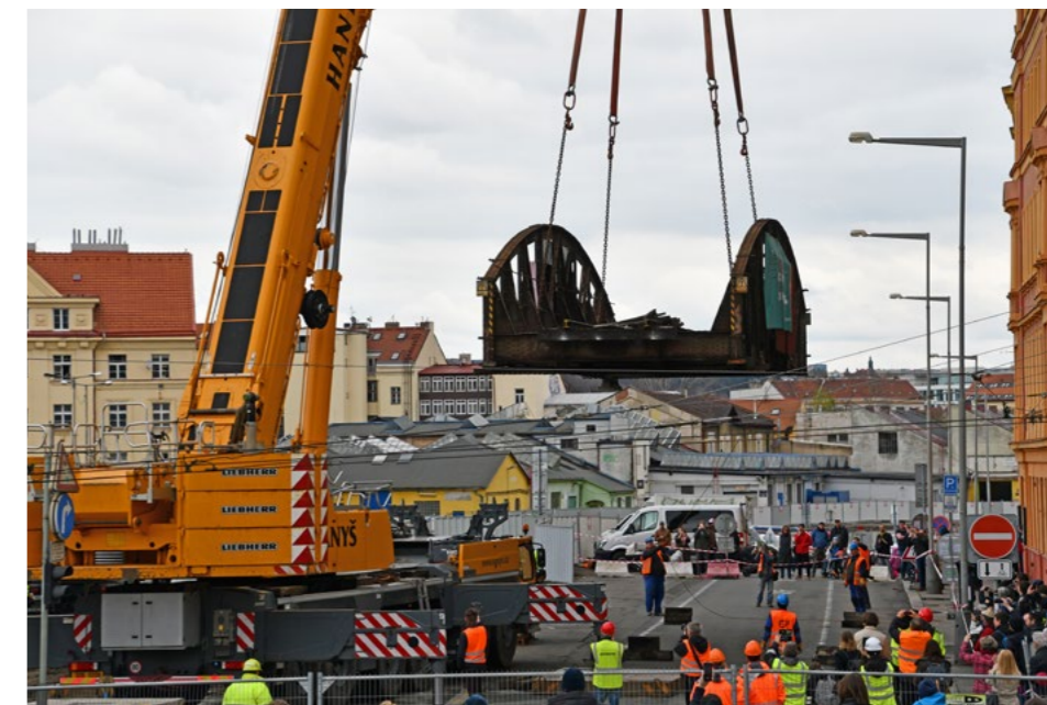
SOBOTA 15. DUBNA 2023 BYLA PRO DESÍTKY ZVĚDAVČŮ PŘÍLEŽITOSTÍ SLEDOVAT ODSTRANĚNÍ PŮVODNÍ MOSTNÍ KONSTRUKCE U VÝSTAVIŠTĚ
