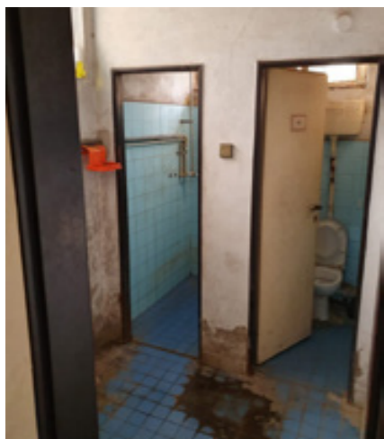
NEUTĚŠENÝ STAV OBJEKTU PŘED REKONSTRUKCÍ V ROCE 2018
