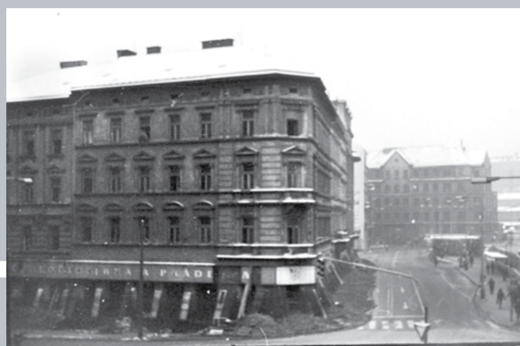
BLOK DOMŮ NA NÁROŽÍ ULIC SOKOLOVSKÉ A KE ŠTVANICI PŘIPRAVENÝ K ODŠTŘELU V SOUVISLOSTI S VÝSTAVBOU VESTIBULU PRO STANICE METRA B A C, 12. 1. 1980
