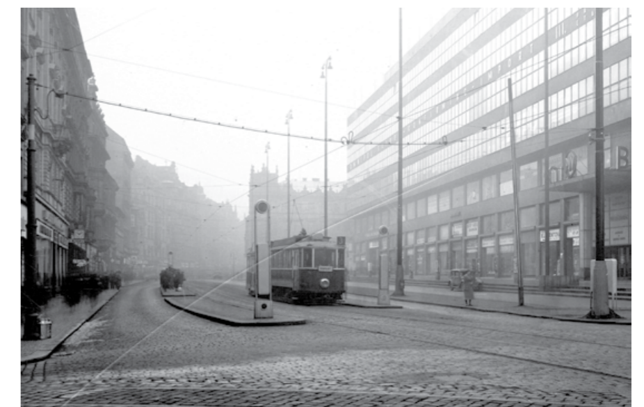
ARCHIV DPP UCHOVÁVÁ I SNÍMEK Z ROKU 1938 OD VELETRŽNÍHO PALÁCE. JEZDÍME JEŠTĚ VLEVO, LINKA 3 JEDE DO KOBYLIS, DO CENTRA ČEKÁJÍ DAVY, NA ZASTÁVKÁCH JSOU NOVÉ OZNAČNÍKY ZNÁMÉ JEŠTĚ Z VÁCLAVSKÉHO NÁMĚSTÍ NEBO NÁMĚSTÍ REPUBLIKY. ZCELA VLEVO STOJÍ TRAMVAJOVÝ SLOUP S OZDOBNOU HLAVICÍ, ZE KTERÉ VEDE NAPÁJECÍ KABEL
