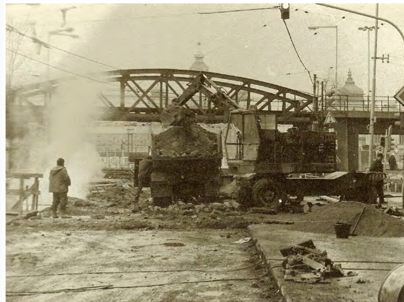
DLOUHÁ LÉTA NEMĚNNÝ, ALE NYNÍ JIŽ NEEEXISTUJÍCÍ MOST BUŠTĚHRADSKÉ DRÁHY PŘES SEVERNÍ KONEC ULICE DUKELSKÝCH HRDINŮ POSLOUŽIL JAKO IDENTIFIKAČNÍ BOD FOTOGRAFIE Z ARCHIVU DPP PORÍZENÉ BĚHEM PANELIZACE TRATI V ROCE 1985. TEHDY POKLÁDANÉ PANELY ZDE VESMĚS VYDRŽELY AŽ DO LETOŠKA
