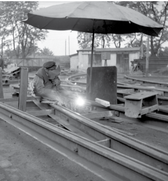
SVAŘOVÁNÍ KOLEJOVÝCH KONSTRUKCÍ NA DVORE RUSTONKY
