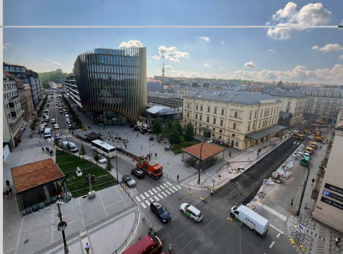
HAVLÍČKOVA ULICE BĚHEM REKONSTRUKCE TRAMVAJOVÉ TRATI A JIŽ DOKONČENÁ REKONSTRUKCE ULICE NA FLORENCI (VLEVO)
