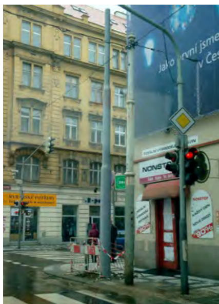
DNE 25. ÚNORA 2013 UŽ VELMI LETITÝ ZDOBNÝ STOŽÁR U VELETRŽNÍ ULICE BYL NA KONCI SVÉ SLUŽBY. JIŽ NESLOUŽIL JAKO NAPÁJECÍ, PO VÝSTROJI ZBYLY JEN DÍRY PO KABELÉCH. DNES TENTO STOŽÁR SLOUŽÍ JAKO PŘIPOMÍNKA U SÍDLA PROVOZU VRCHNÍ VEDENÍ V AREÁLU ÚSTŘEDNÍCH DÍLEN V HOSTIVÁŘI
