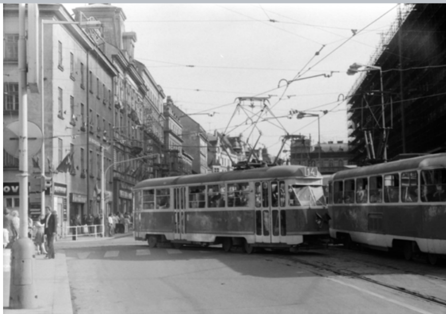
NA PRVNÍHO MÁJE 1977 VYFOTIL IVO MAHEL „TÉ JEDNIČKU“ JEDOUcí Z VELETRŽNÍ ULICE DO DUKELÁKŮ NA LINCE 14. JIŽ 5. KVĚTNA 1977 ZDE „ČTRNÁCTKA“ PŘESTALA JEZDIT. VELETRŽNÍ PALÁC JE PO POŽÁRU V LÉTĚ 1974 JIŽ POKRYT LEŠENÍM, KTERÉ TAM BYLO VELMI MNOHO LET. ZDOBNÝ SLOUP VLEVO JE OPATŘEN ODPOJOVAČEM ELEKTRICKÉHO NAPÁJENÍ Z MEZ MOHELNICE. SEMAFORY ZE SIGNALBAU HUBER MNICHOV ZDE SLOUŽILY JEŠTĚ 17 LET (VIZ ČLÁNEK V DP KONTAKTU 5-6/2024)
