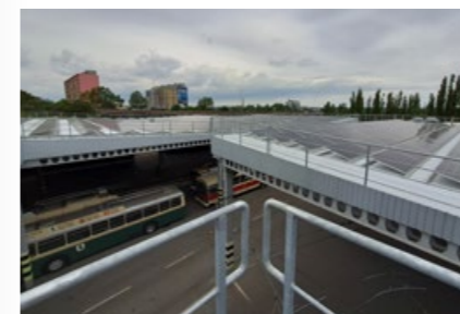
FOTOVOLTAICKÁ ELEKTRÁRNA NA ZASTŘEŠENÝCH ODSTAVECH
