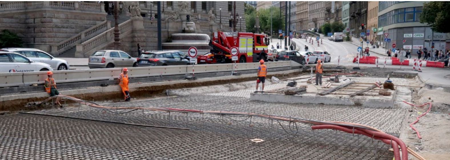
MONTÁŽ PRVNÍCH VÝZTUŽÍ PŘI OPRAVĚ STROPNÍ DESKY ČÁSTI VESTIBULU STANICE METRA MUZEUM NA POČÁTKU ZÁŘÍ 2024
