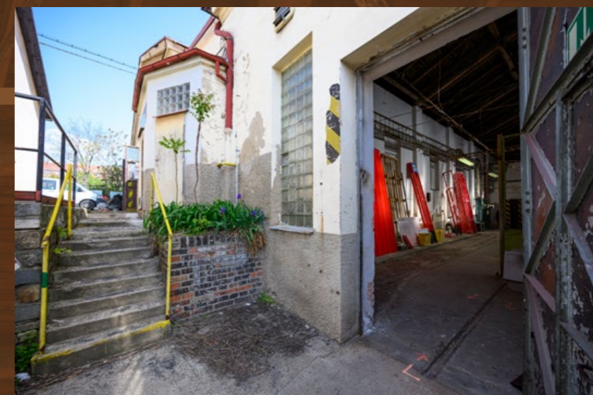
V ROCE 1952 DOŠLO K PŘÍSTAVBĚ PĚTIÚHELNÍKOVÉ VRÁTNICE, A TO PŘED SPOJOVACÍ CHODBU DO DÍLNY (VLEVO NA SNÍMKU S LUXFERAMI), PO ZRUŠENÍ SE NA MÍSTĚ NACHÁZELA PLYNOVÁ KOTELNA. VPRAVO NA SNÍMKU JSOU DVEŘE DO STŘEDNÍ HALY, ZBYLÁ PŮVODNÍ VRÁTA NAHRADILY LUXFERY. ZA POVŠIMNUTÍ STOJÍ I ZABETONOVANÉ ZBYTKY PŮVODNÍCH KOLEJÍ Z ROKU 1898. JEDNÁ SE VŠAK O JINÝ TYP KOLEJNIC NEŽ V HORNÍ HALĚ
