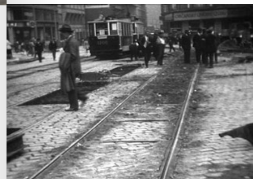
JEŠTĚ JEDNOU SRPEN 1930 A ZAČÍNÁJÍCÍ REKONSTRUKCE NÁMĚSTÍ REPUBLIKY. TRAMVAJE JEŠTĚ JEZDÍ PO STARÝCH KOLEJÍCH, ALE PODĚL NICH JSOU UŽ PŘIPRAVENY PROVIZORNÍ POVRCHOVÉ KOLEJE, NA KTERÉ BUDE PŘEVEDEN PROVOZ
