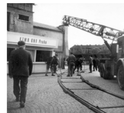
STAVBA POVRCHOVÉ KOLEJE V PARKU KULTURY A ODDECHU V ROCE 1956, KDY BYLA POUŽITA K PŘEPRAVNÍM A VÝSTAVNÍM ÚČELŮM
