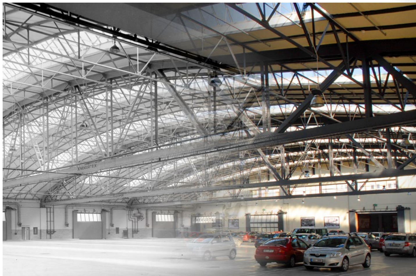
ČERSTVĚ DOKONČENÁ HALA AUTOBUSOVÉ GARÁŽE DEJVICE V PROSINCI 1932 PŘED NASTĚHOVÁNÍM PRVNÍCH AUTOBUSŮ. NA BAREVNĚ ČÁSTI SNÍMKU PAK NA STEJNÉM MÍSTĚ PARKOVIŠTĚ KAUF LANDU NA STĚNÁCH S VELKOFORMÁTOVÝMI FOTOGRAFIEMI Z VÝSTAVY PŮVODNÍ GARÁŽE
