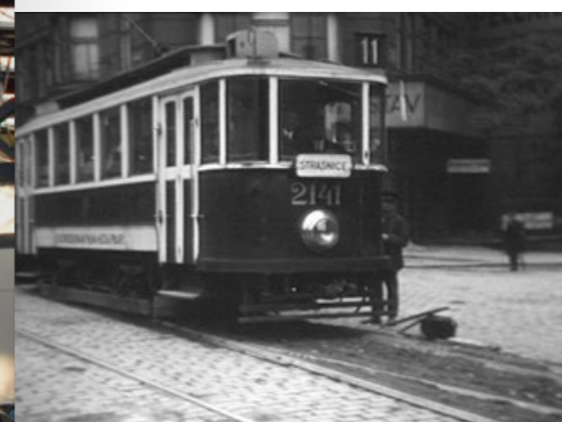
TRAMVAJOVÝ VLAK NAJÍŽDÍ V SRPNU 1930 NA NÁMĚSTÍ REPUBLIKY NA POVRCHOVOU VÝHYBKU A NAVAZUJÍCÍ POVRCHOVOU KOLEJ PROVIZORNÍ PŘELOŽKY
