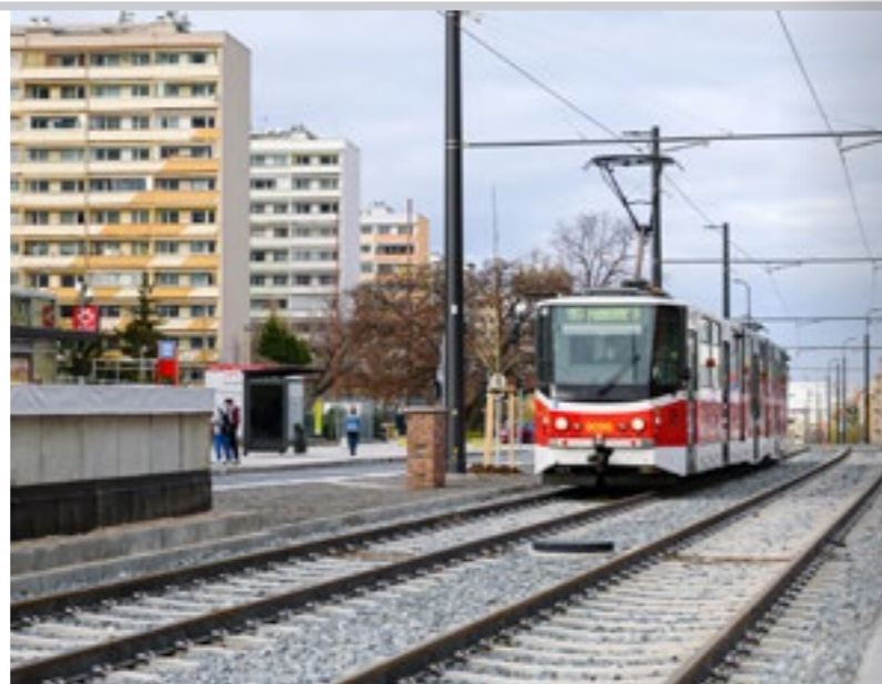
...A V OPAČNÉM SMĚRU DO KONEČNÉ ZASTÁVKY MÍŘÍ VŮZ V PŮVODNÍM NÁTĚRU. ZÍDKA V LEVÉ STRANĚ SNÍMKU PATŘÍ BUDOUCÍMU PODCHODU DO OBOU STANIC METRA
