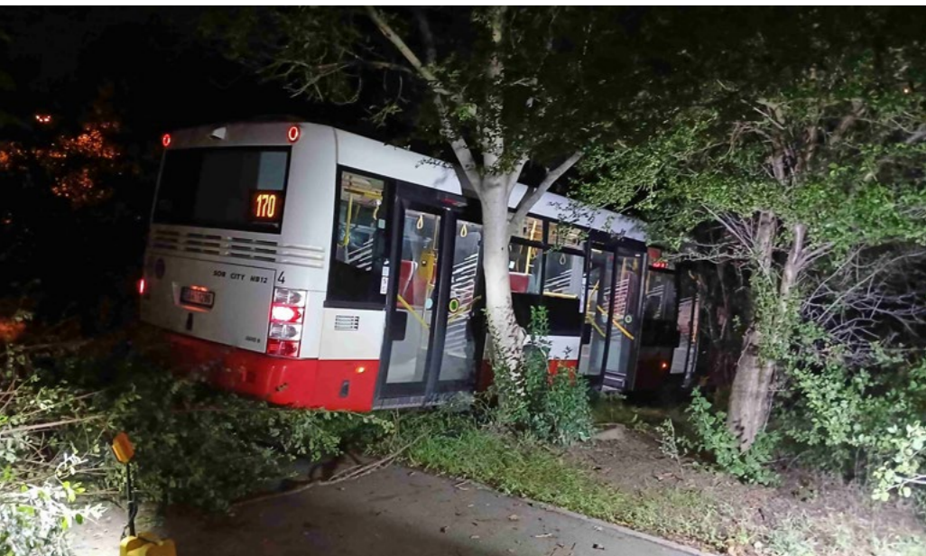
TŘI HODINY TRVALO ODSTRAŇOVÁNÍ NÁSLEDKŮ NEHODY V ULICI KUNÍNOVA 18. 9. 2024. K UVOLNĚNÍ AUTOBUSU, KTERÝ SJEL MIMO KOMUNIKACI A ZAKLÍNIL SE O STROMY, BYLO NUTNÉ NEJPRVE NASADIT MOTOROVÉ PÍLY A PŘIPRAVIT PŘÍSTUP PRO JEŘÁBOVOU TECHNIKU
