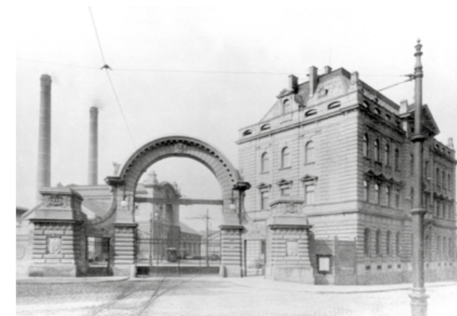
HONOSNÝ VJEZD DO AREÁLU HOLEŠOVICKÉ ELEKTRÁRNY V ROCE 1900
