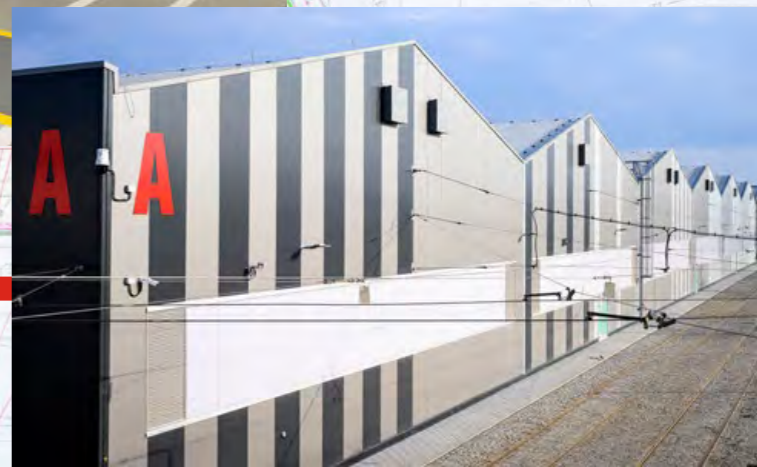
PŘED ZÁVĚRKOU – POHLED NA ZÁPADNÍ STRANU VOZOVNY HLOUBĚTÍN Z 11. BŘEZNA 2025
