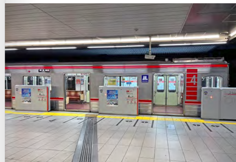
VĚTŠINA STANIC METRA V JAPONSKU MÁ AUTOMATICKÁ NÁSTUPIŠTNÍ VRATA. TENTO SYSTÉM TVOŘÍ BARIÉRA V PODOBĚ RŮZNĚ VYSOKÉHO PLOTU S POSUNOVACÍMI DVEŘMI, NEJČASTĚJI SKLENĚNÝMI. STĚNA NEDOSAHUJE AŽ KE STROPU A ZCELA NEODDĚLUJE STANICI OD KOLEJÍ
