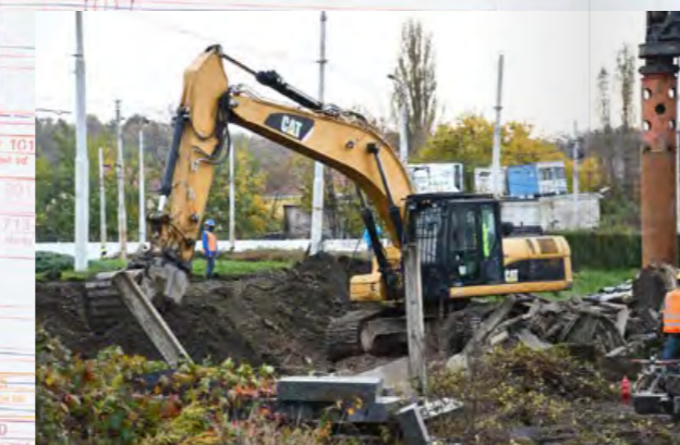
5. LISTOPADU 2020 DOCHÁZELO UŽ K PRVNÍM PRACEM V AREÁLU. SNÍMEK ZE ZAHÁJENÍ VÝSTAVBY ENERGOCENTRA A MĚNIRNY, KTERÉ JIŽ DNES ZÁSObUJÍ AREÁL VOZOVNY A PŘÍLEHLOU TRAMVAJOVOU TRÁŤ TEPEM A ELEKTRICKOU ENERGIÍ...
